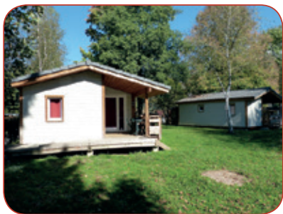
Maître d'ouvrage Commune de La Rochette
